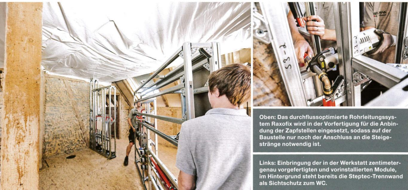
Oben: Das durchflussoptimierte Rohrleitungssystem Raxofix wird in der Vorfertigung für die Anbindung der Zapfstellen eingesetzt, sodass auf der Baustelle nur noch der Anschluss an die Steigstränge notwendig ist.
